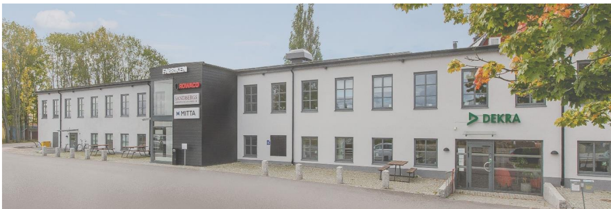
Råggatan 16–18, kontorsfastighet med solcellsanläggning.
